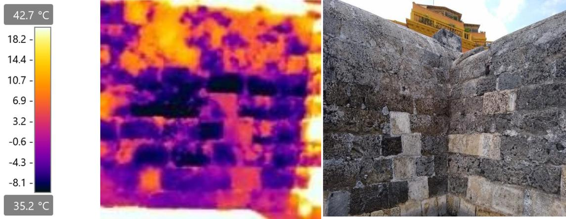
*Ilustración 83. Termográfica de la patología #20 con respecto a las piedras aledañas*
