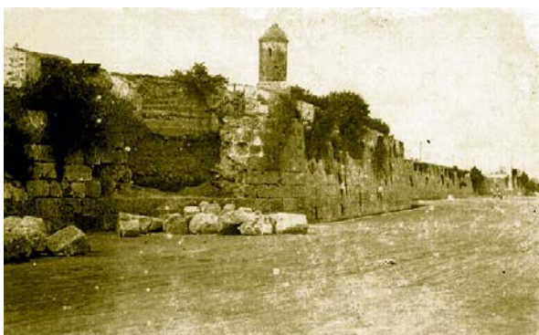
Espacio de muralla desaparecido
