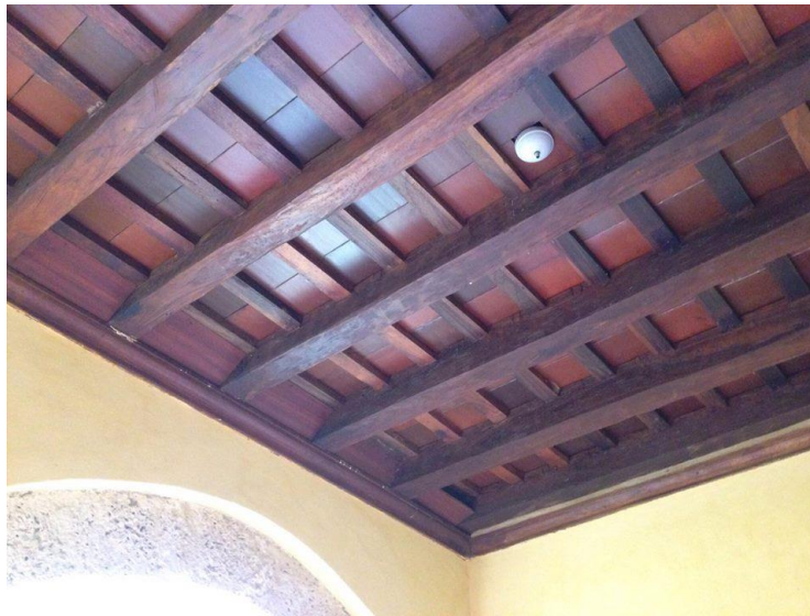
Figura 2. Cubierta Plana en Terraza. Fuente: Autores
