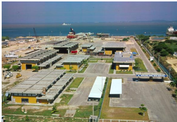
Figura 2. Instalaciones de la Planta Mamonal.
