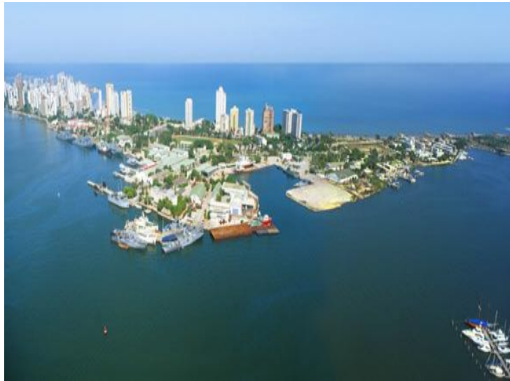
Figura 3. Ubicación de la Planta Bocagrande.
