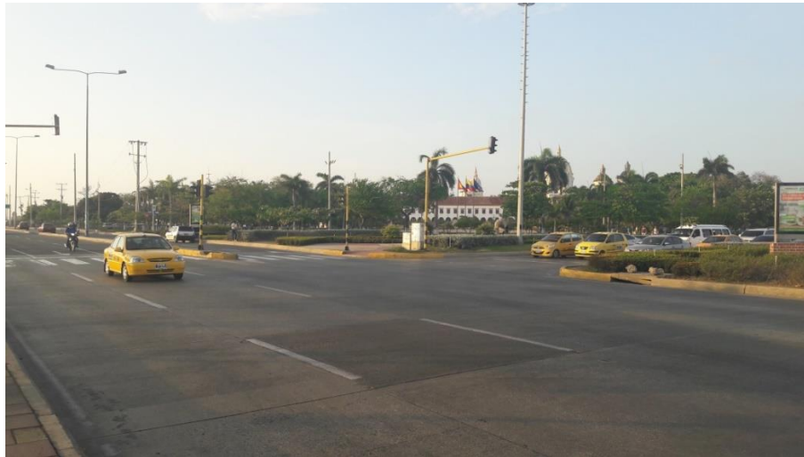
Figura 27. Vista general de la intersección 5.
