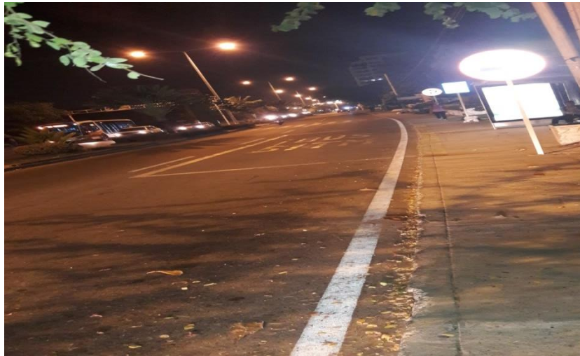
Figura 11. Señalización vertical y horizontal del Tramo Centro - Crespo.
