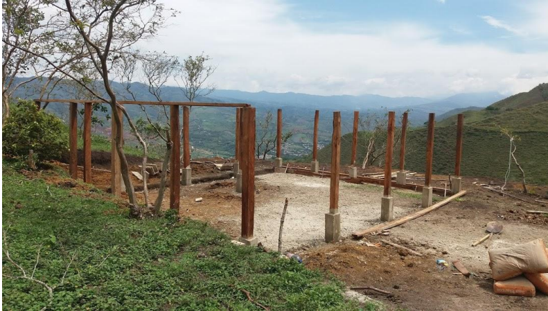
Fotografía 4. Construcción del establo comunitario "Rosal alto" en el Marco del proyecto PNUD
