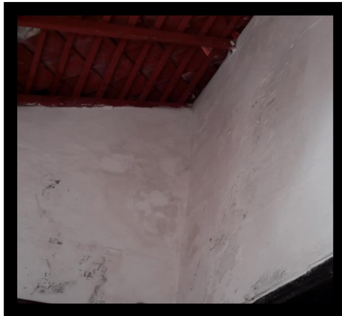
Ilustración 29 Estado de los muros
