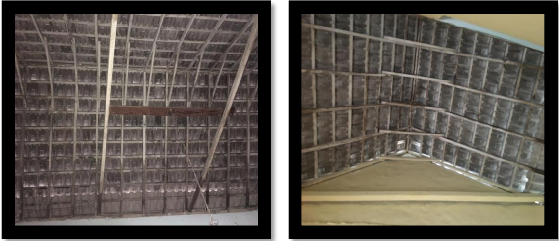
Ilustración 14 Cubierta de la casa
