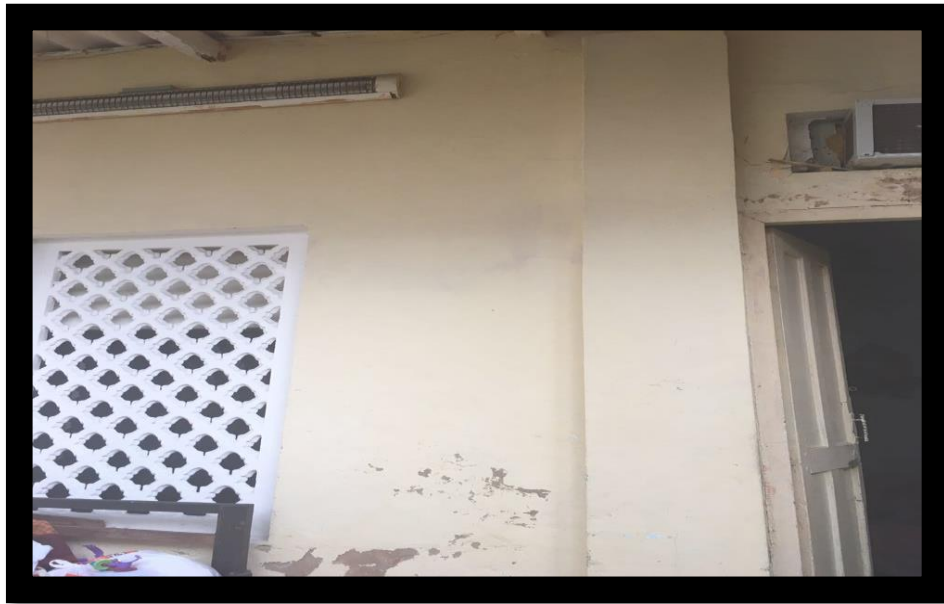
Ilustración 10 Conservación de los muros
