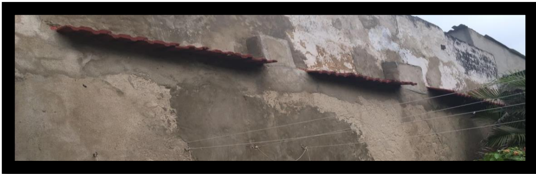
Ilustración 15 Elementos no estructurales
