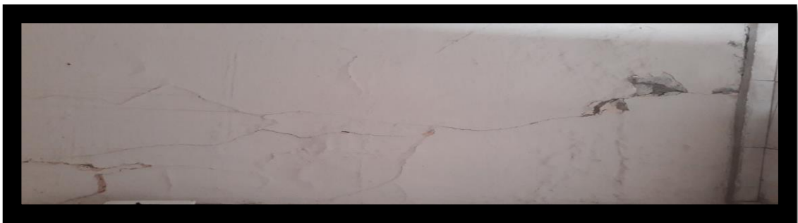
Ilustración 36 Estado de los muros
