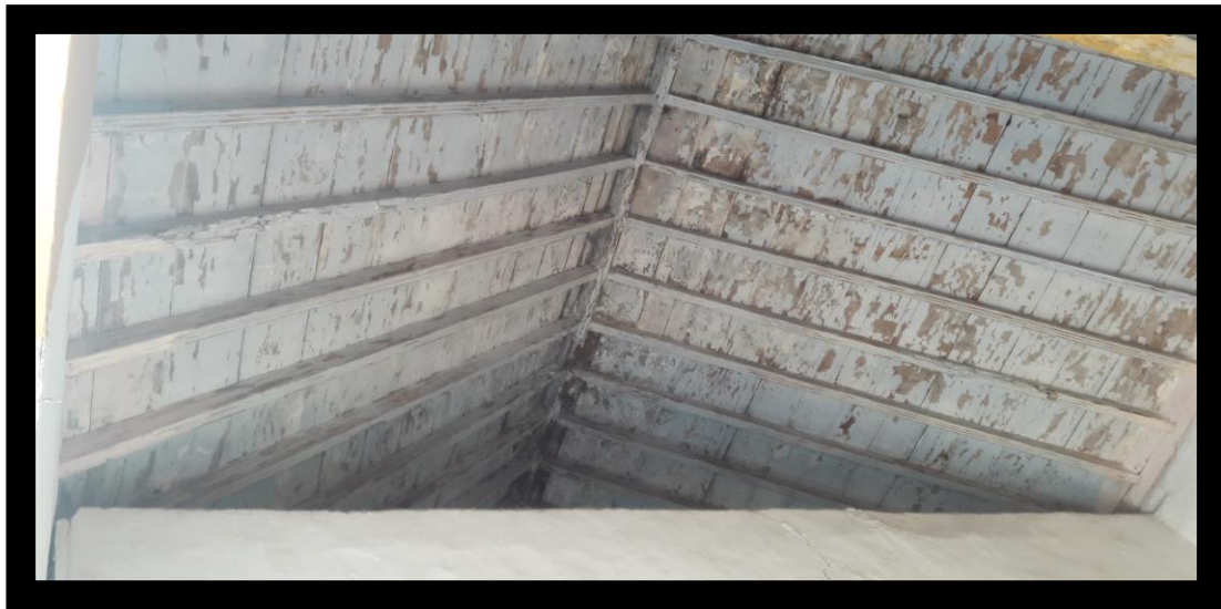
Ilustración 34 Cubierta de la casa
