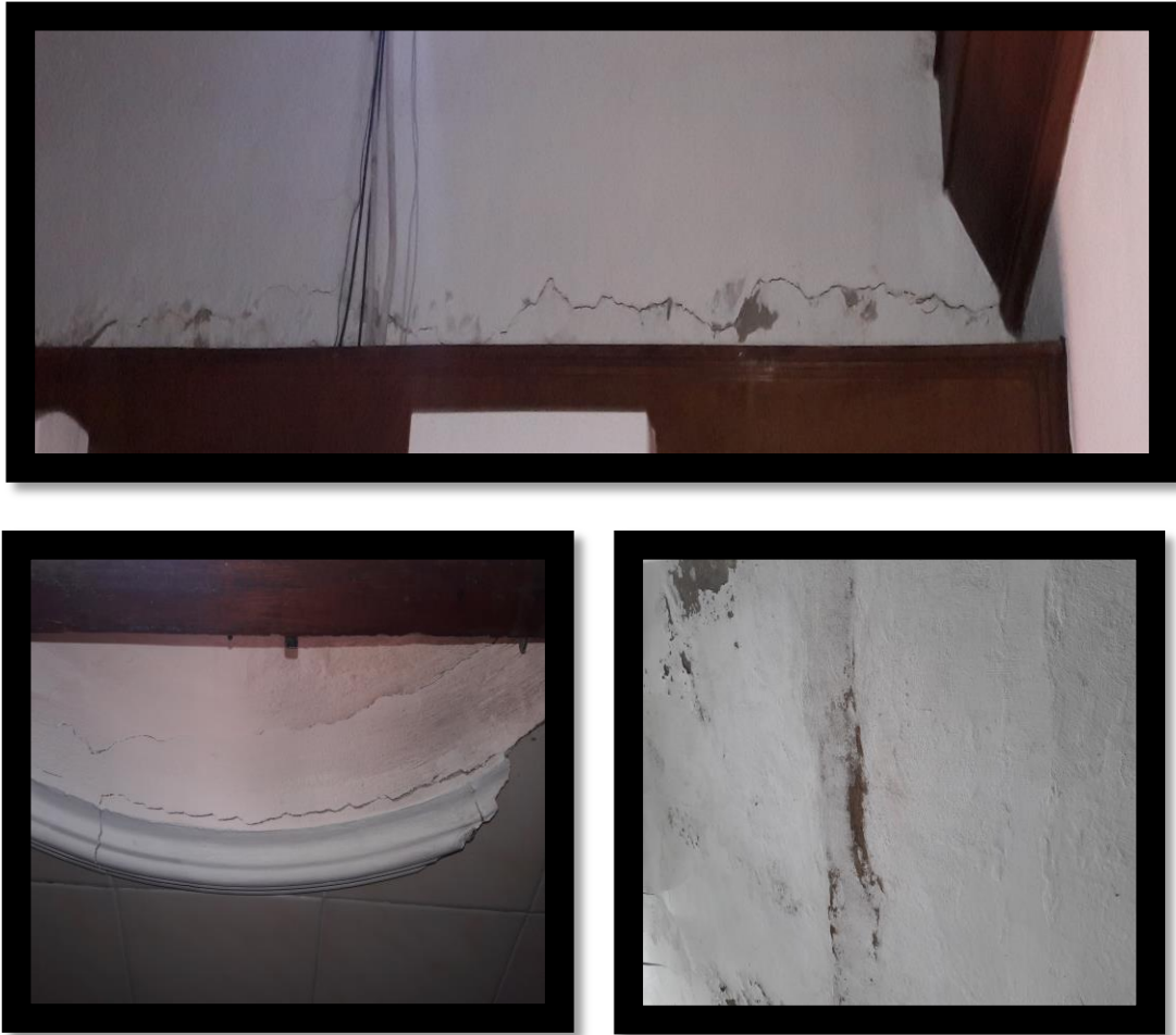
Ilustración 23 Estado de los muros
