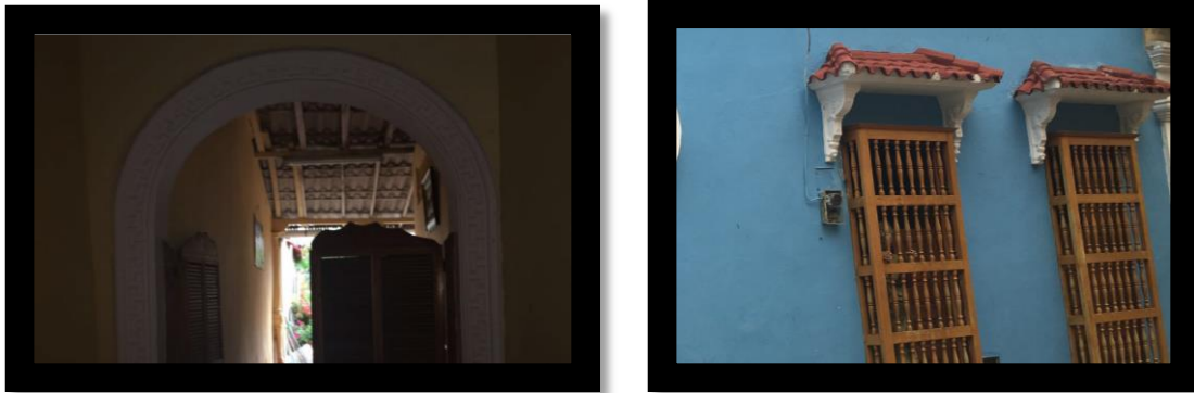
Ilustración 16 Elementos no estructurales
