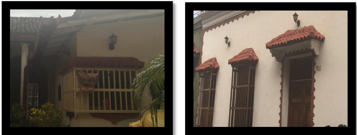
Ilustración 9 Elementos no estructurales
