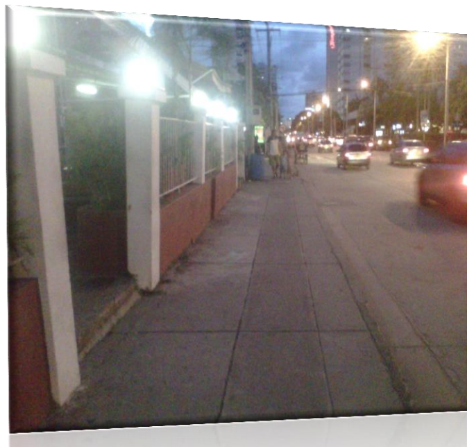
Ilustración 62. 2 ° Avenida entre Calles 9-10 Anden B
