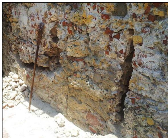
*Ilustración 11 - Extracción del bloque de mampostería colonial mixta*
