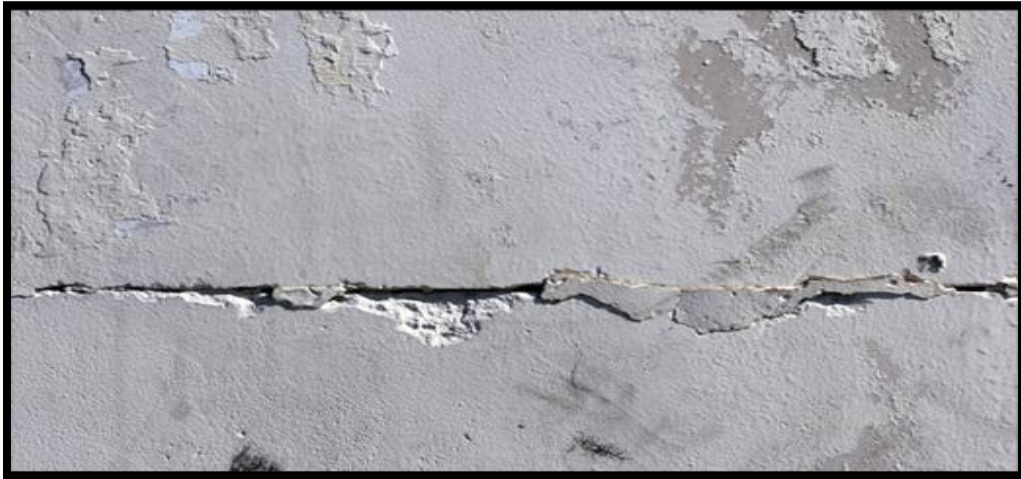
Anexo 6. Corrosión por grietas o hendiduras
