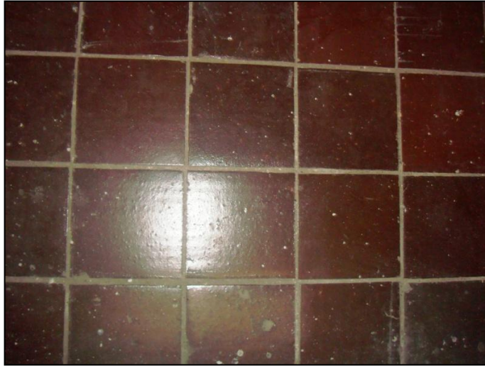
Figura 7-2. Piso del entrepiso (coro).
