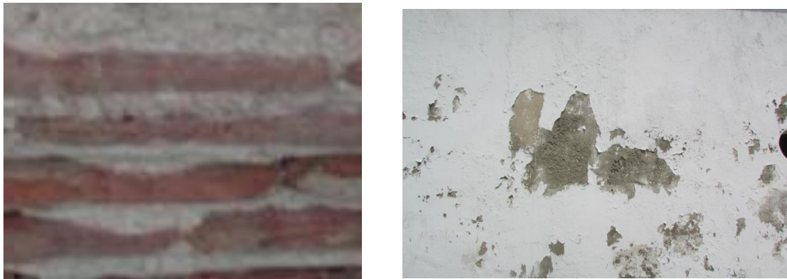
Ilustración 6-1 Muros portantes tableta militar tipo III. Fuente Autores
