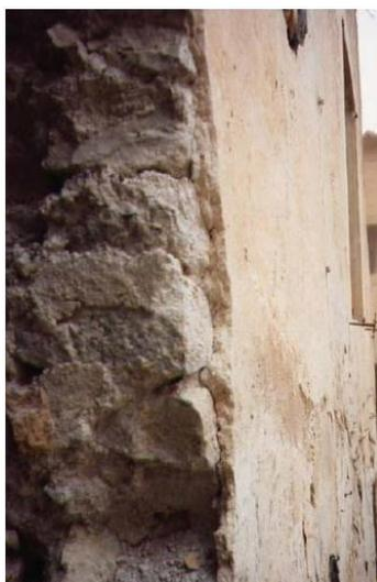
**Foto 7. Sección del muro. Nótese como se ve la piedra calcárea y la argamasa.**
