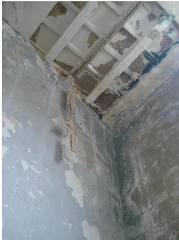
**Foto 10. Viga en estado de corrosión y con desprendimiento del recubrimiento.**
