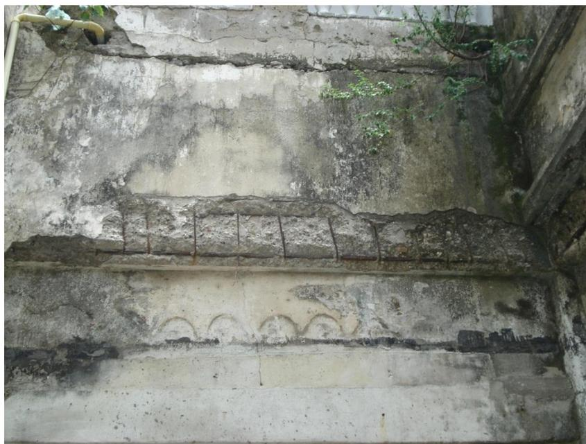
**Foto 1. Nótese como la viga ha perdido su recubrimiento, dejando el hierro expuesto.**
