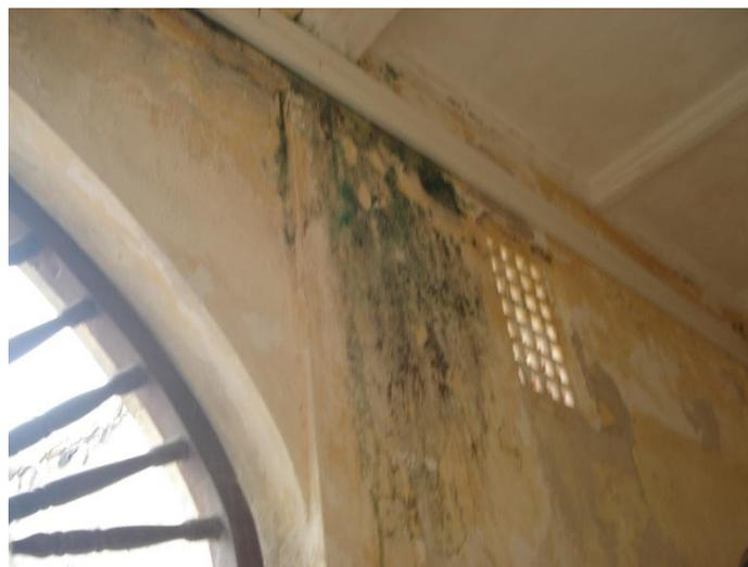
**Foto 8. Presencia de humedad en muro.**
