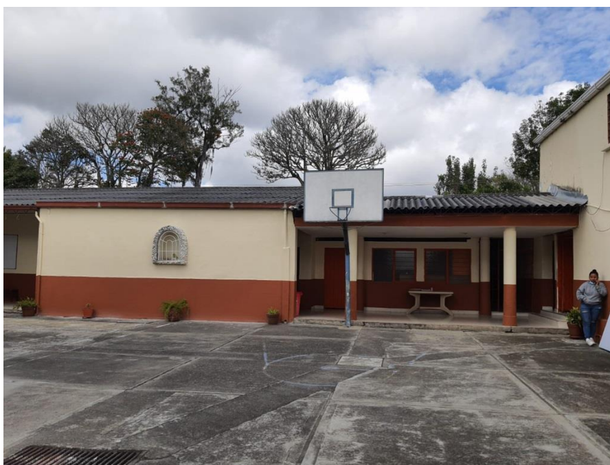
Foto 7. Sede José Antonio Galán 2. (2022) Patio 2. Patio 1. (Grados 3ro, 4to y 5to).
