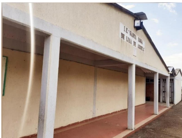
Figura 4 Fachada de la I.E. Santa Rosa de Lima – Sede Principal Arbela.
