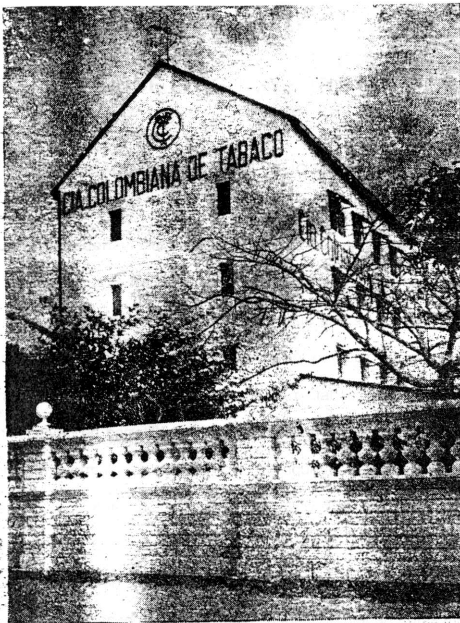
Parte alta del edificio de la Fábrica de la Compañía Colombiana de Tabaco , situado en el barrio de Manga.
