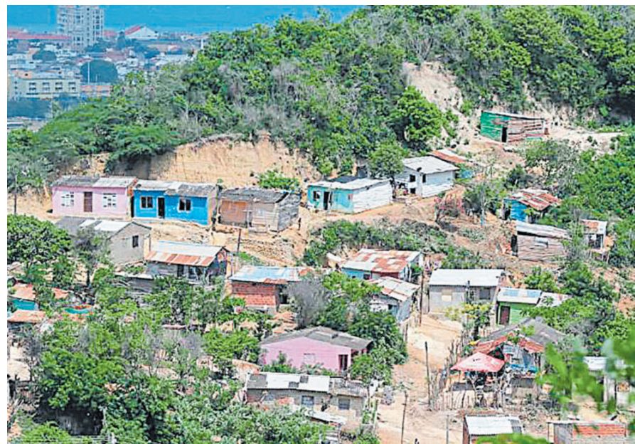
■ Entre las recomendaciones hechas por los expertos, está la reubicación de cientos de familias que viven en las laderas del cerro, quienes serían los primeros afectados de un eventual desprendimiento de material rocoso.
