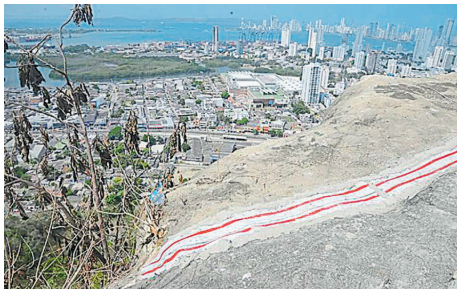
■ Los ingenieros confirmaron que la grieta que afecta al “Salto del Cabrón”, avanzó 1.5 milímetros de dilatación en las últimas semanas.
