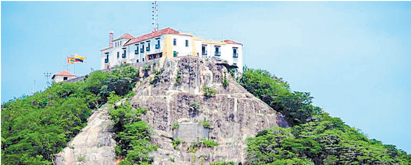
■ La intervención humana, la deforestación y las fuertes corrientes de aguas lluvias son señaladas como las causas en el deterioro del cerro de La Popa.
