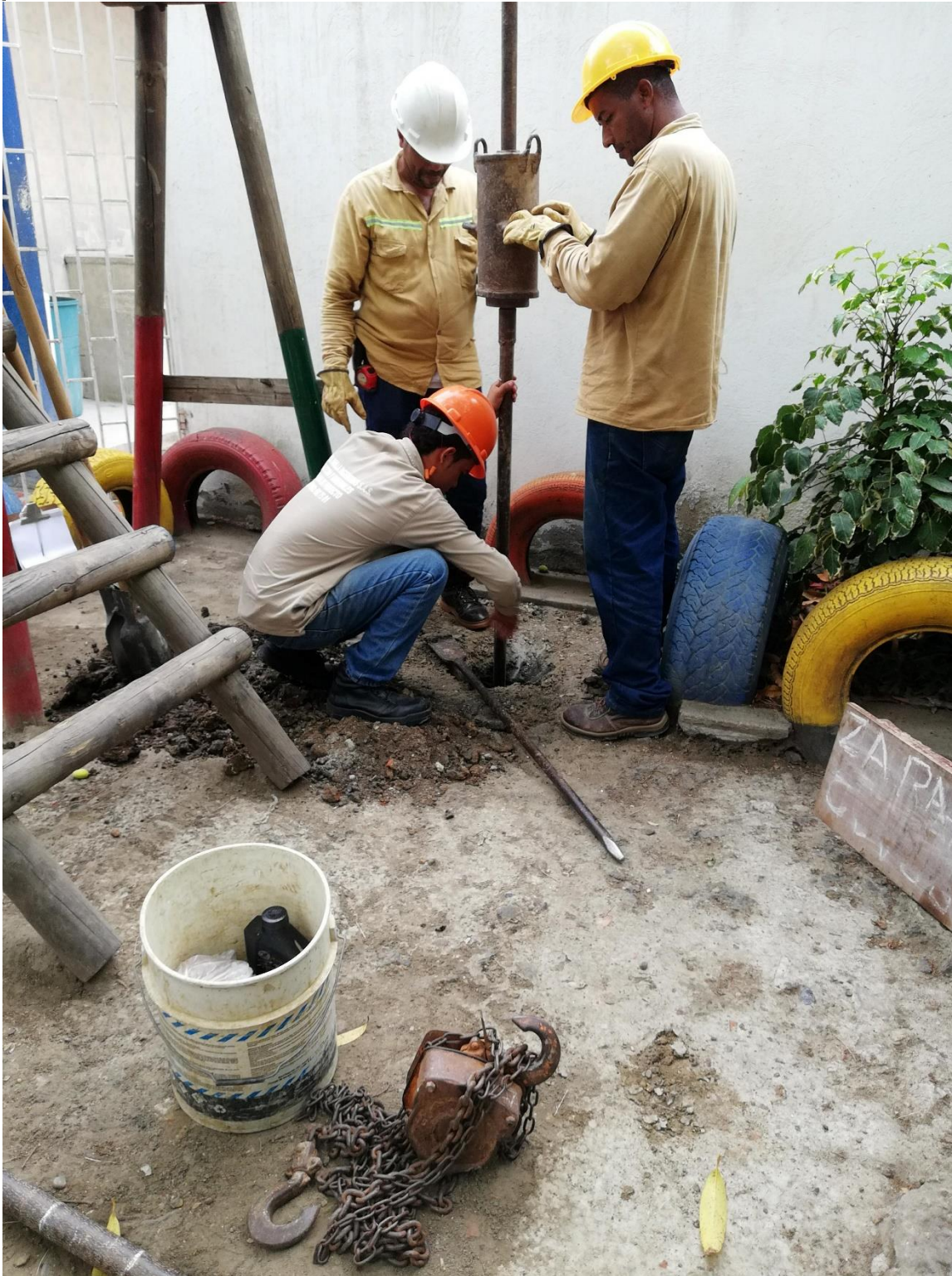
Imagen 1. Extracción de muestras de suelo mediante sondeos SPT. Fuente: elaboración propia.
