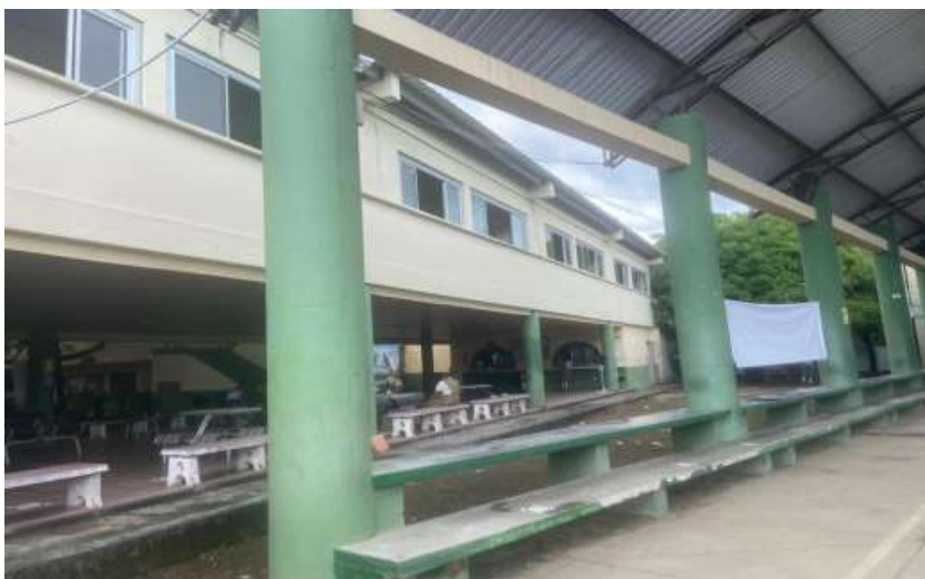
Figura 4 Vista interior de la I.E Mercedes Abrego, Montería – Córdoba
