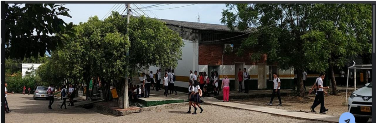
Figura 5. Sede Central de la Institución
