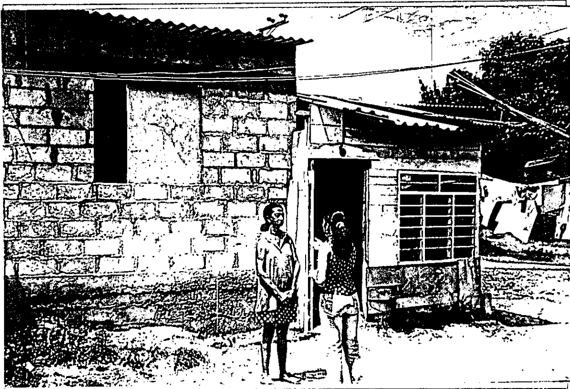
Foto 7. Aspecto exterior de vivienda mejorada. Beneficiaria Guillerma Loreta
