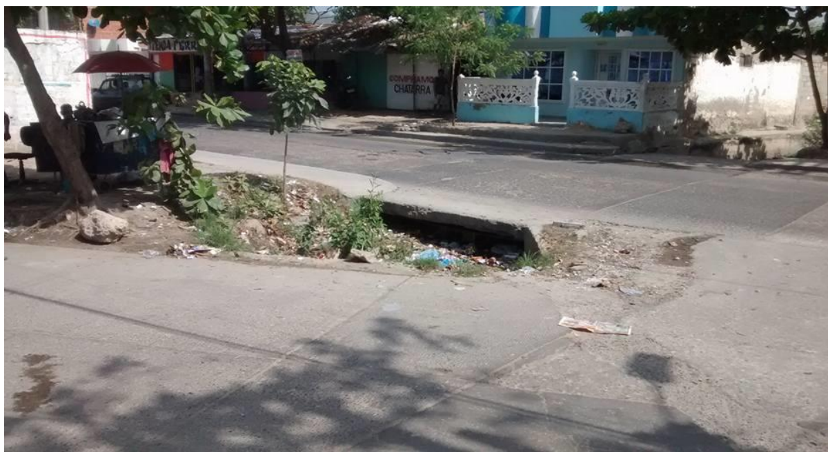
Alcantarillado frente a la Institución Educativa Ciudad de Tunja. Fotografía de Autores.
