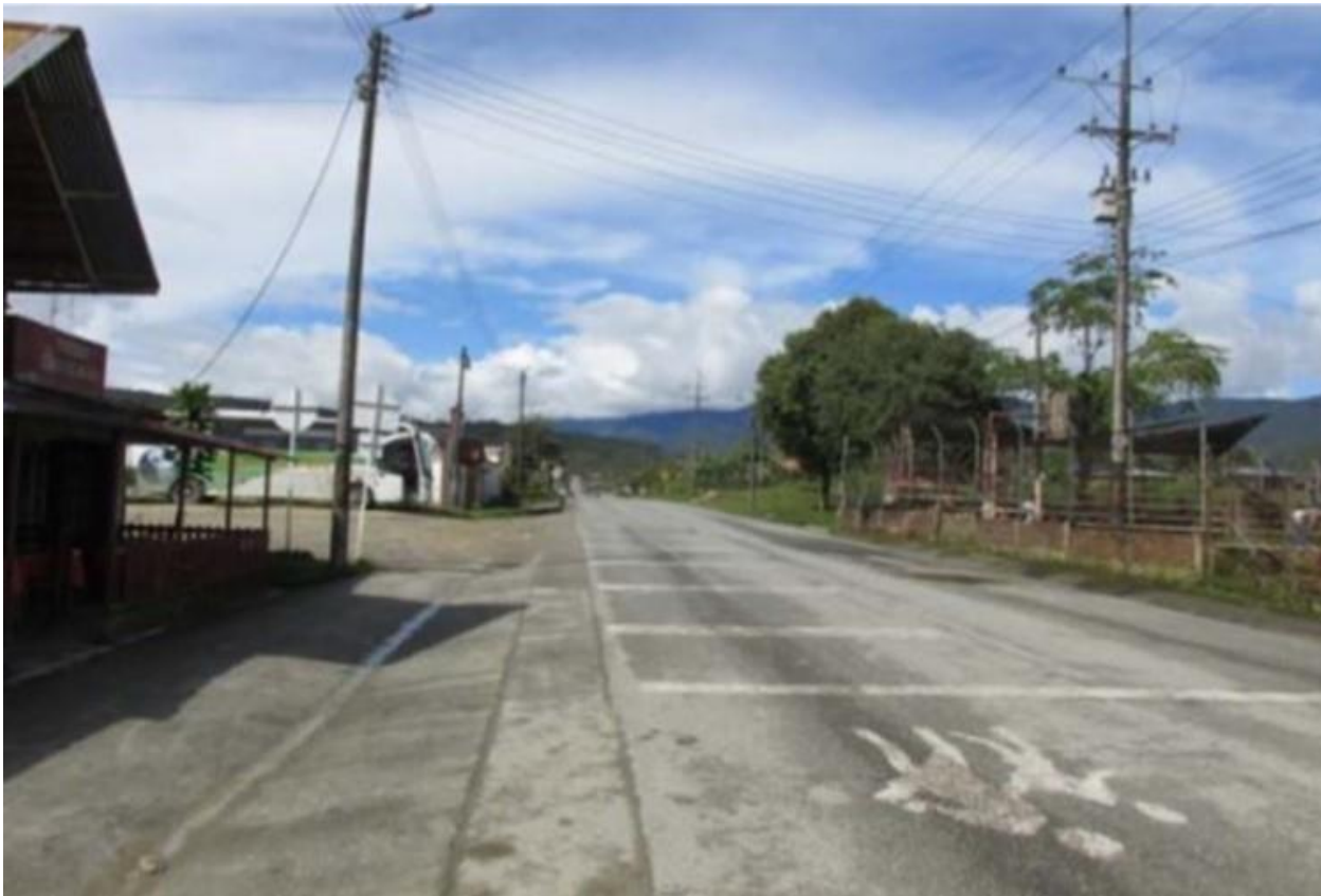
Fotografía 3. Carretera Pitalito – Mocoa en dirección Sur – Norte. A la altura de San Juan de Villalobos. A la derecha se encuentra la Escuela Primaria de San Juan, a la izquierda se encuentra un Hotel-Restaurante. Fuente: “Diagnóstico, identificación y valoración económica de servicios ecosistémicos, municipios de San Juan Nepomuceno y Santa Rosa de Cauca”
