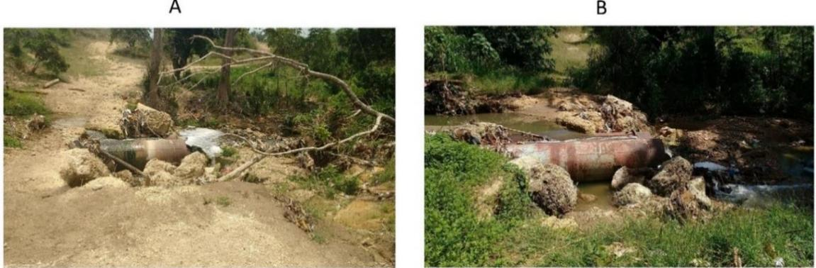
En la Figura 25 se puede observar el punto P5 del recorrido, existe socavación en las paredes del canal en época de verano (A) motivando a los habitantes de la zona a hacer rellenos artesanales, y peor aún en época de lluvias, que el camino existente desaparece por el desborde del arroyo (B). Además de esto, presenta erosión en la parte superior de la pared del canal.
