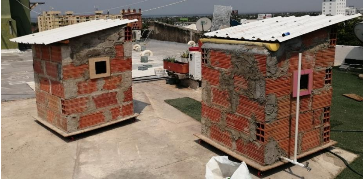
Ilustración 72. Evidencia fotográfica de las unidades a escala de laboratorio terminadas con dirección Oeste de muro experimental y control.
