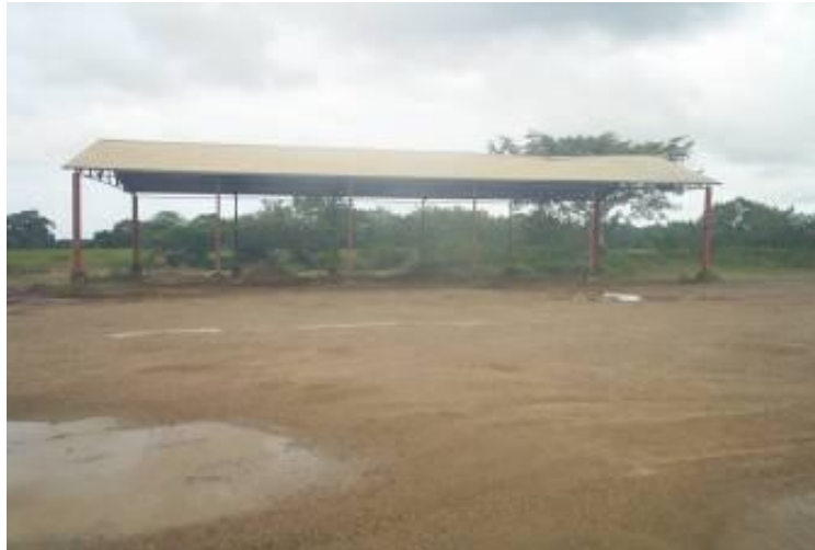
Ilustración 7. Bodega de materiales
