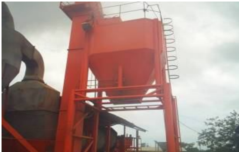
Ilustración 14. Elevador, Homogeneizador y Silo de almacenamiento
