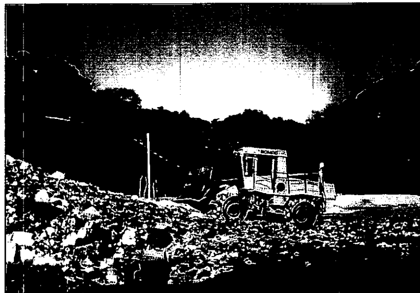
Ilustración 6. Esparcido y compactación de residuos
