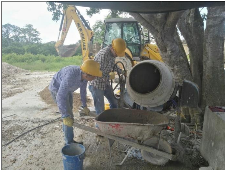
Figura 5. Elaboración de la mezcla de concreto
